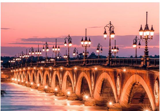
Victime d'un tassement léger mais continu (plusieurs millimètres par an sur les piles 7 à 16, centrales), d'infiltrations d'eau en raison d'un plateau de surface perméable et d'une vulnérabilité
